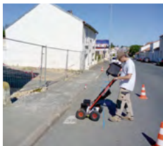
Détection des réseaux au géoradar
