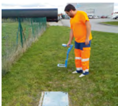
Détection des réseaux au RD8000
