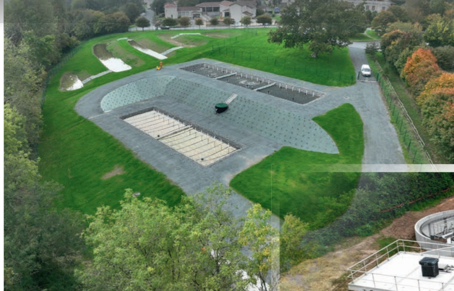
> STATION D'ÉPURATION FPR
