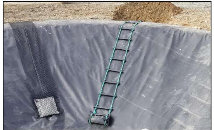
L'échelle de corde est réalisée à partir de cordage en polypropylène et de barreaux en PEHD. Elle offre ainsi une très forte résistance à la traction mais aussi une bonne tenue dans le temps.
