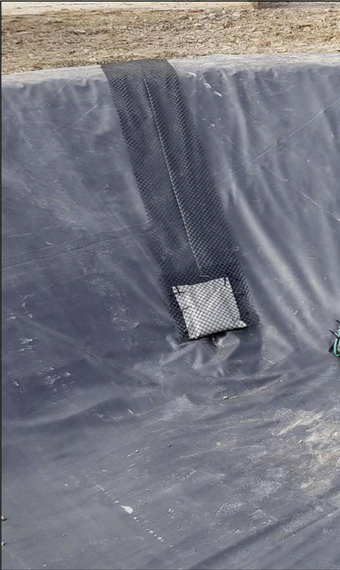
L'**échelle à rongeurs** est fortement recommandée sur les ouvrages en géomembrane, dès que la pente est importante. Cela permet aux animaux tombés dans le bassin de sortir sans faire d'accrocs dans la géomembrane.
